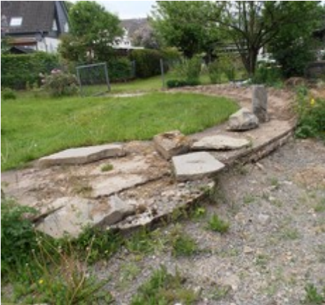
Rest einer Betonbahn in der Wiese
